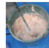
5 固さに応じて水を少量ずつ加えながら粘度の調整を行ってください。混ぜ合わせが不十分ですと、色むら、剥離、すさの塊の原因となりますので注意してください。
