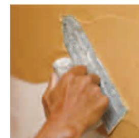
7 1.5mmほどの厚さで塗ってください。この時下地が透けないように注意してください。(施工目安は、1袋(1kg入り)3~5㎡です。塗り厚や水の量などによって、施工面積は変わります。)
