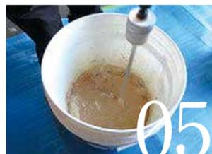
固さに応じて水を少量ずつ加えながら粘度の調整を行ってください。混ぜ合わせが不十分ですと、色むら、剥離、すさの塊の原因となりますので注意してください。
