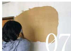
1.5mmほどの厚さで塗ってください。この時下地が透けないように注意してください。(施工目安は、1袋(1kg入り)約3m<sup>2</sup>です。塗り厚や水の量などによって、施工面積は変わります。)
