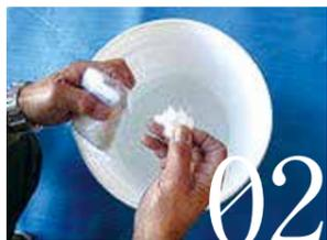
別のバケツに約5リットルの水と「すさ(別袋)」と「防カビ液(別ボトル)」を入れます。薄い混濁が見られます。
